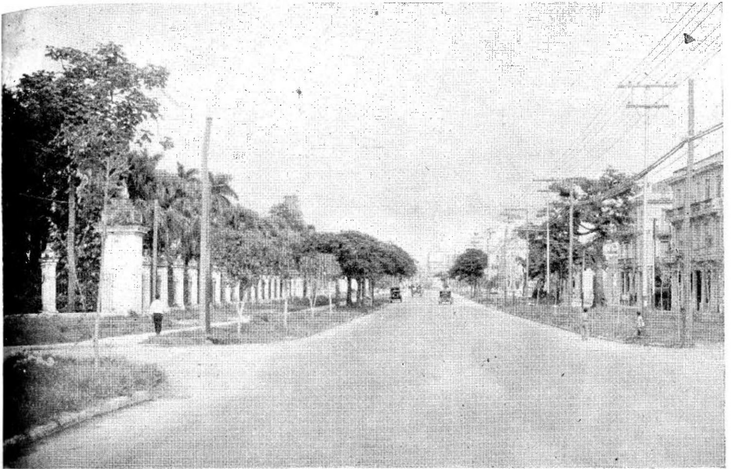
Una sección del Paseo de Carlos III, como aparece actualmente, después de realizadas las obras de reconstrucción.—(Foto VALES.)
